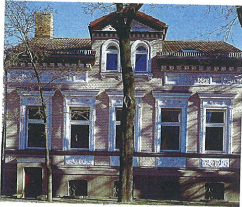
Originalgetreu sanierte Fassade
